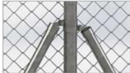
Payanda Bağlantı Detayı Brace Fixation detail
