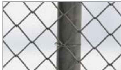
Tel Bağlantı Detayı Tie Wire Fixation Detail
