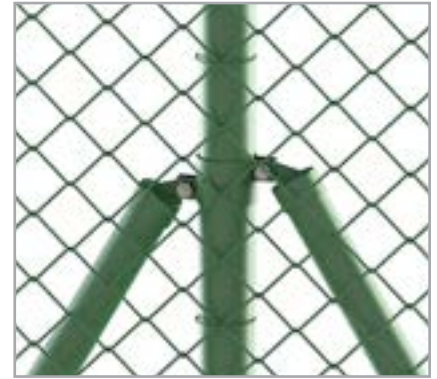
Payanda Bağlantı Detayı Brace Detail
